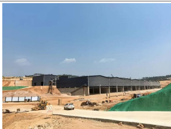
项目整体现状
