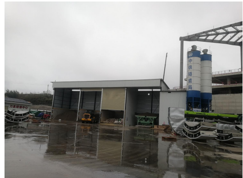
砂石料堆场封闭厂房
