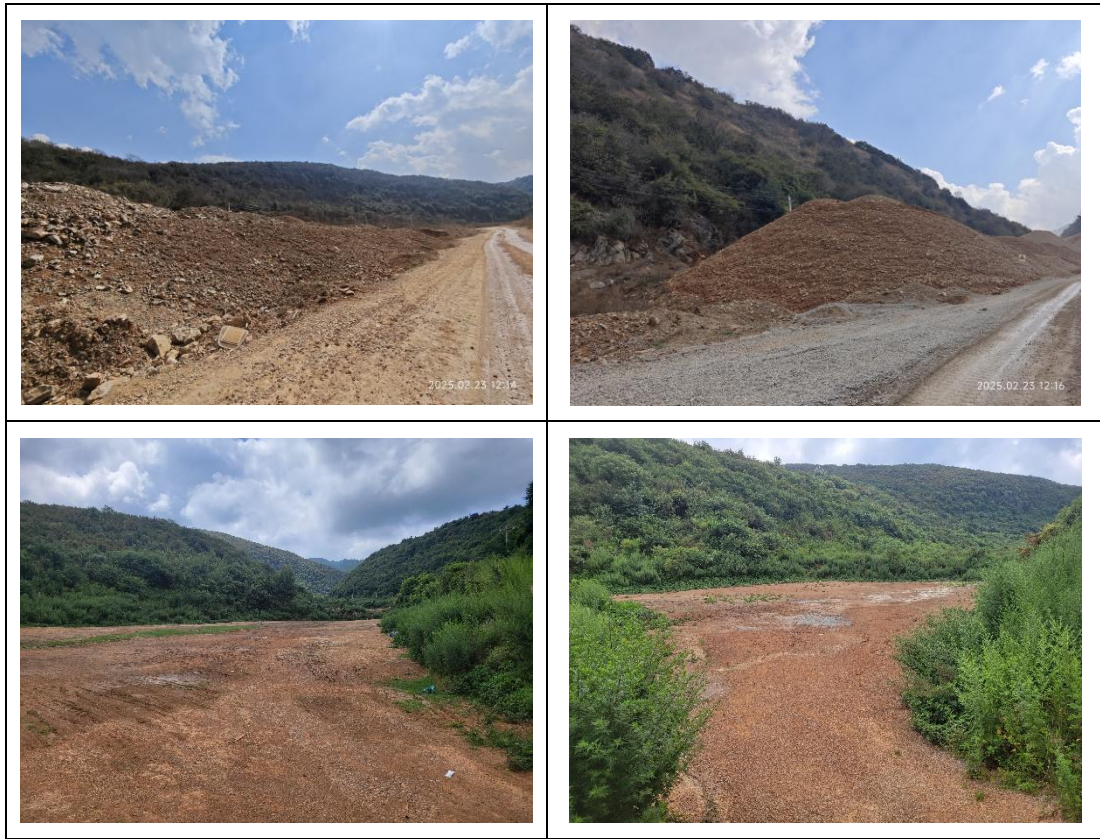
照片 3.2-3 项目区矿山道路及周边损毁照片合集
