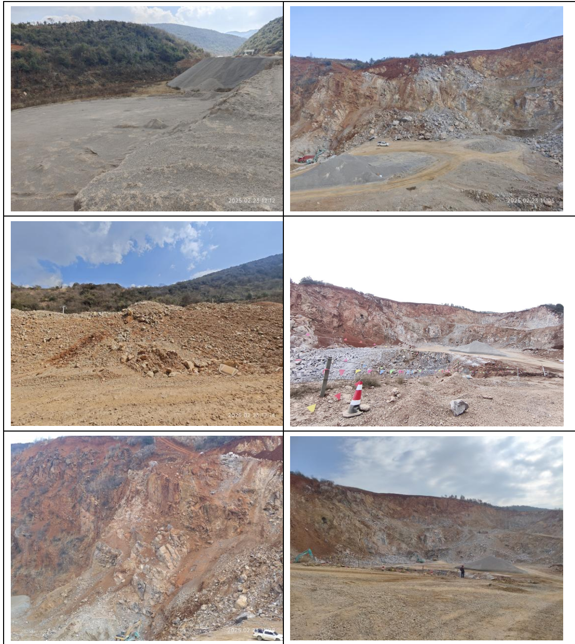
图 3-2-2 野毛冲矿区生态修复施工现状照片
