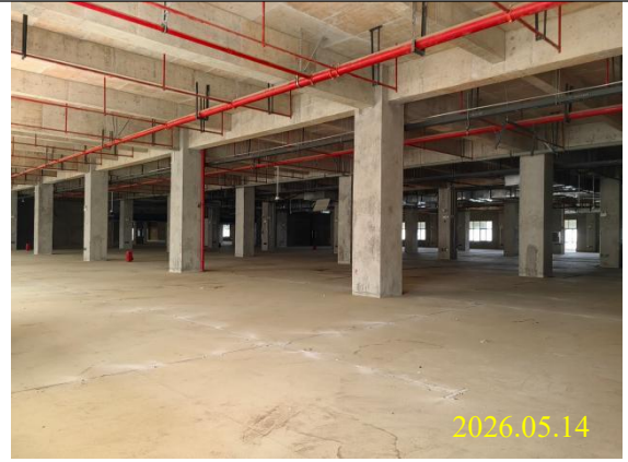
项目厂房内部3层
