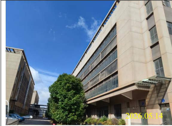
项目生产厂房现状
