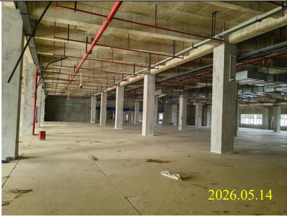
项目厂房内部4层
